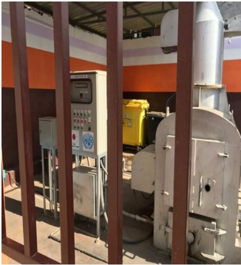
Figure 3: Incinérateur à double chambre sans fumée CHU Joseph Raseta Befelatanana
